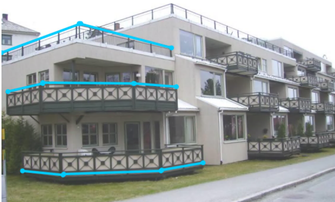
Figur 52. Eksempel på registrering av Veranda med forskjellige høydereferanser (ikke alle Verandaer på bildet er illustrert med en egen strek)
