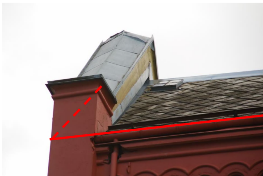
Figur 8. Eksempler på registrering av takkant der det er en opphøyet kant ved takflaten. I disse tilfellene skal høyden på takkanten registreres på takplanet og ikke på de oppstikkende objektene. Takkant er tegnet med rød strek.
